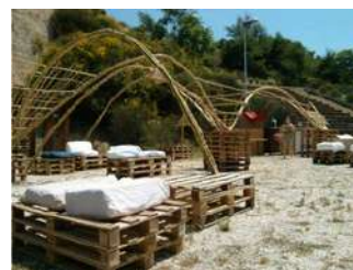
Una tettoia in bambù costruita dal gruppo Poliedra
