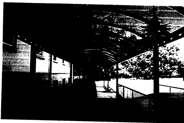
Passerella coperta di raccordo con struttura in alluminio e lastre in policarbonato compatto adatta per la realizzazione di tunnel protettivi per scale esterne, collegamenti tra edifici e cancelli pedonali. Il fissaggio viene effettuato tramite tasselli in acciaio o tassello chimico che permette di evitare opere murarie e di lattoneria.
