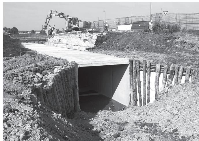
Infine, è in fase di ultimazione il **ponte sul Canale dei Mulini a Taglio Corelli**. Collocata la struttura scatolare prevista per la composizione del nuovo ponte alla fine di settembre, al momento in cui si scrive è in corso la realizzazione della sede stradale e entro la fine del mese di ottobre i lavori saranno completati, permettendo così la riapertura della viabilità. Contestualmente si procederà alla realizzazione delle piste ciclabili laterali.
